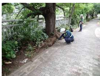
(外観診断の状況)
