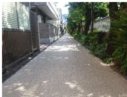
(透水性カラー舗装整備後)
