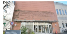
防災センター
