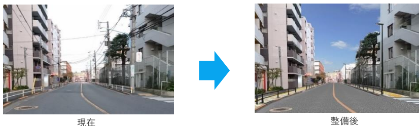
道路の無電柱化【女子医大通り】
