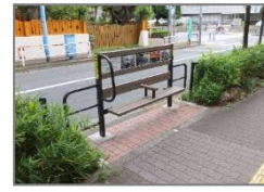
防護柵ベンチの設置
