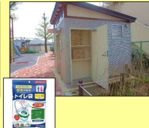
トイレの倉庫内に備蓄している携帯トイレ（トイレ袋）
