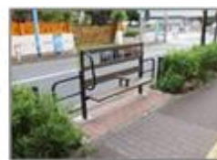
防護柵ベンチの設置
