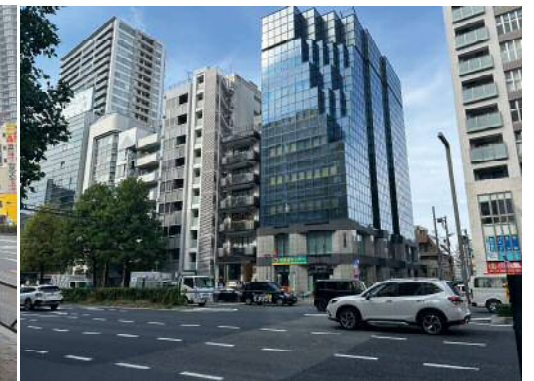
③新宿通り北側 第12大鉄ビル
