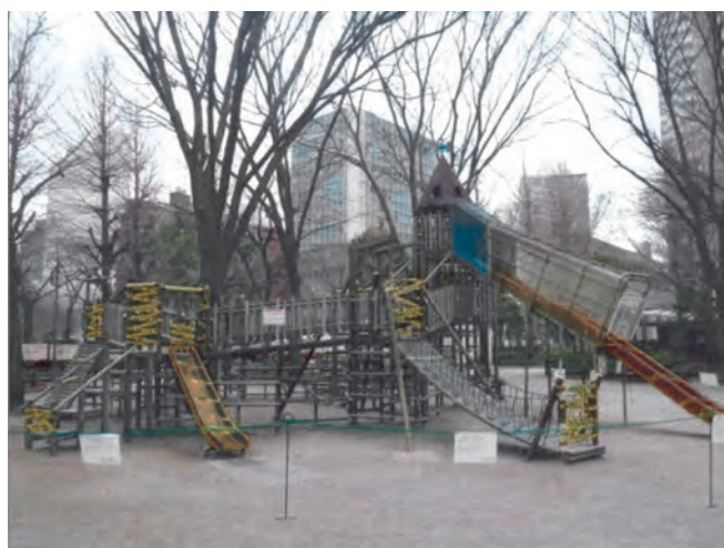
老朽化した遊具 (平成29年3月に撤去)
