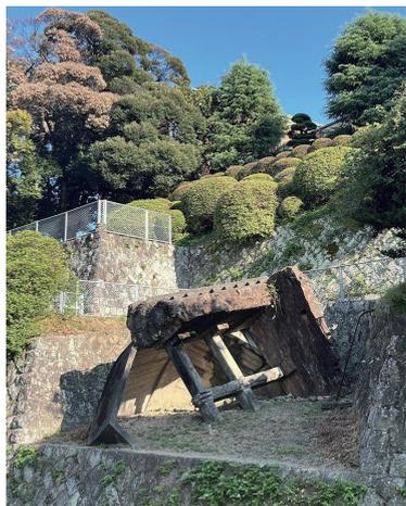
落下した鐘楼（鉄筋コンクリート製 推計約50t）
