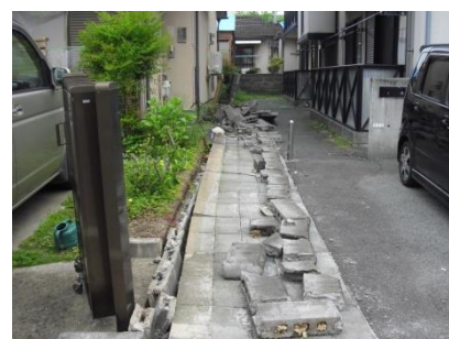
熊本地震の被害状況
