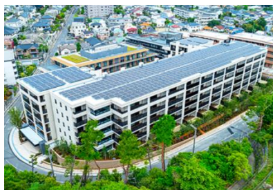
太陽光発電設備の事例 出典: 環境省HP
