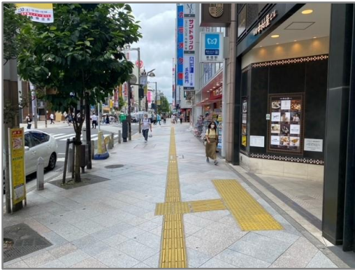
視覚障害者誘導用ブロックの連続設置
