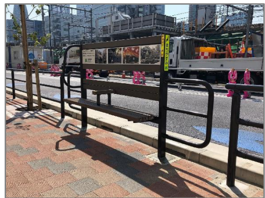
防護柵ベンチの設置
