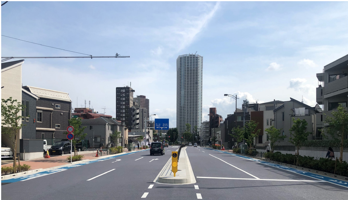
整備が完了した環状第4号線（余丁町・河田町区間）
