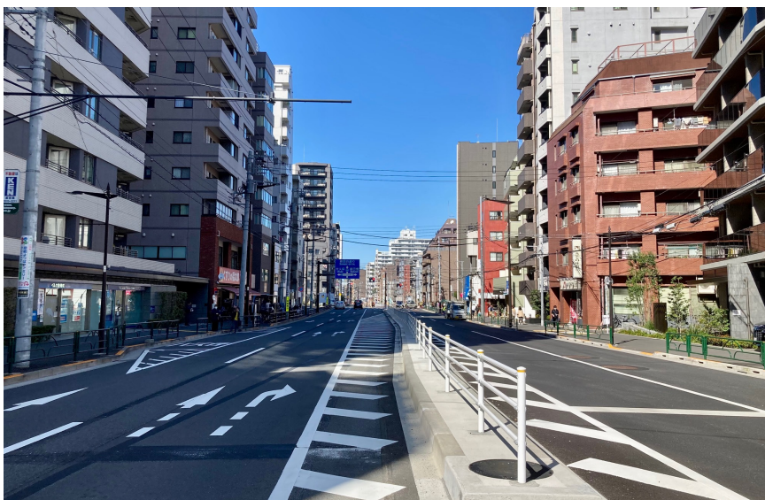
整備が進む環状第3号線(外苑東通り)
