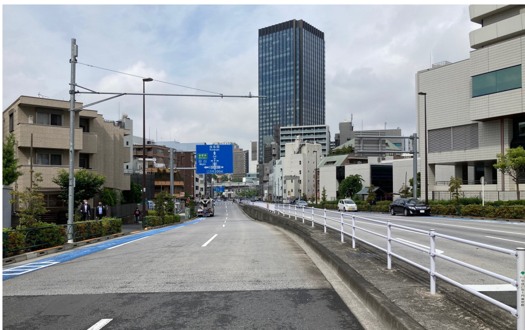
整備が完了した放射第25号線
