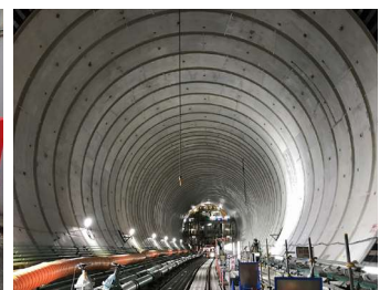
環状七号線地下広域調整池の整備
