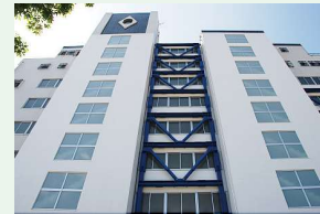
マンションの耐震改修工事の事例
