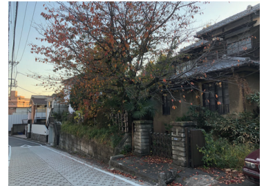
■開放的な塀やさく、大谷石積みの下部
