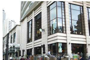
建築物と一体的な屋外広告物
