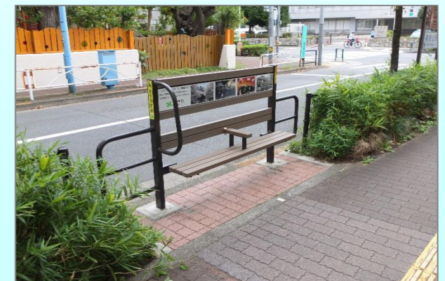
防護柵ベンチの設置
