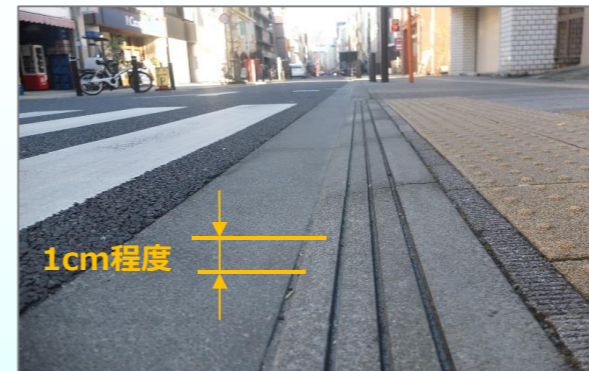
歩車道縁石ブロックの段差1cm化 (※バリアフリーの法令上は2cmが標準とされている)
