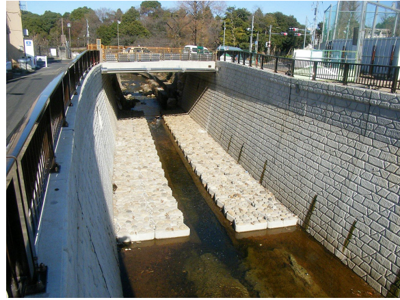
河川の時間降雨50mm対応護岸整備(妙正寺川)
