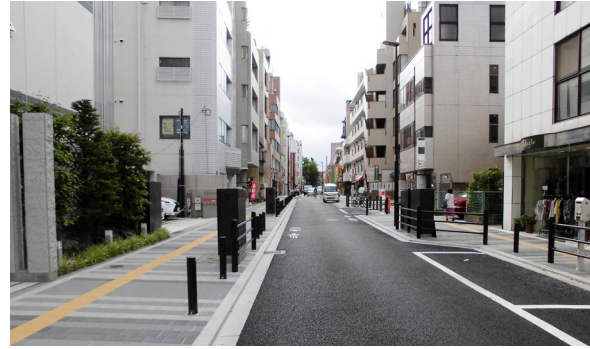
道路の無電柱化の事例(三栄通り)
