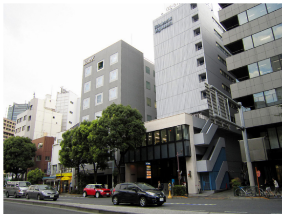
建替えによる建物の耐震化の事例(目白通り沿道)
