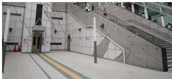
駅周辺のバリアフリー動線の充実の事例(新宿駅東南口)
