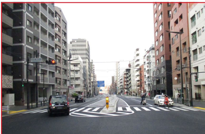
整備が進む環状第3号線(外苑東通り)
