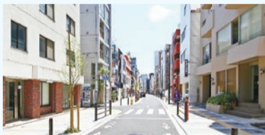
▲無電柱化した道路
