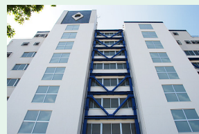
マンションの耐震改修工事の事例
