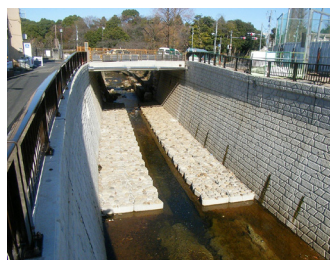
妙正寺川の護岸改修
