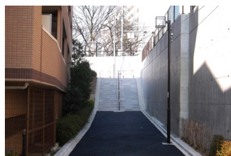
改修した擁壁(写真右側)
