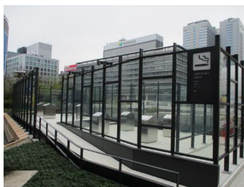
新宿駅西口公衆喫煙所（令和2年4月整備）
