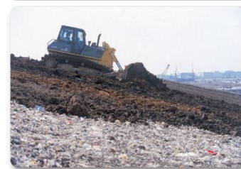
埋立作業・覆土作業の様子
