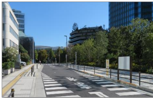
無電柱化された道路空間（コモレ四谷）
