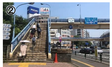
老朽化した歩道橋(昭和43(1968)年の竣工から50年以上が経過)
