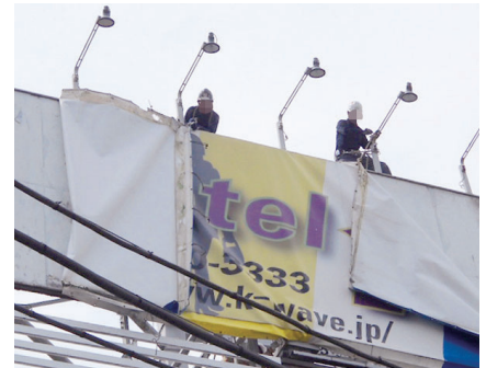
屋外広告物の安全対策
