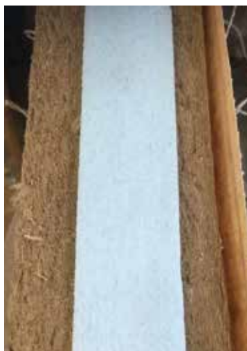
木屑を固めたボードで発泡ポリスチレンフォームを挟んでいる現代の豊床。
