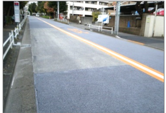
遮熱排水性舗装の施工状況（西落合二丁目地区）
