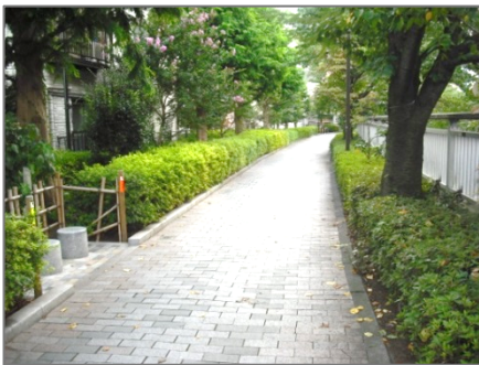
遊歩道の整備
