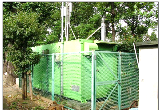
四谷自動車排出ガス測定局
