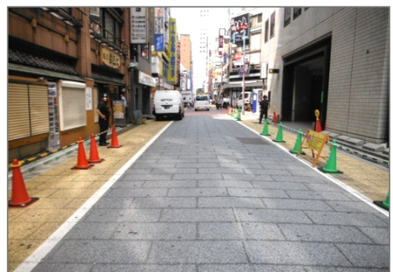
保水性舗装の施工状況（西新宿一丁目地区）
