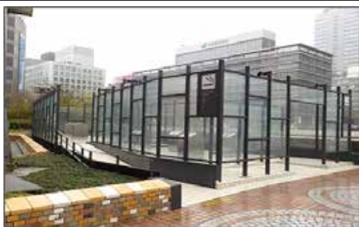
<新宿駅西口公衆喫煙所(令和2年4月開設)>
