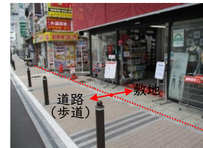
◎道路整備により、敷地と道路の段差解消がされている
