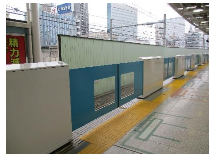
◎ホームドアを整備している
