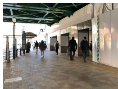
早稲田通りガード下の歩道拡幅 （高田馬場駅前）
