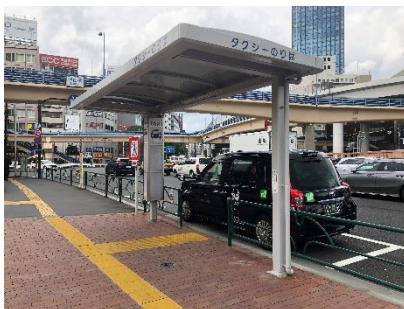
◎タクシー乗降場に上屋や誘導用ブロックが設置されている
