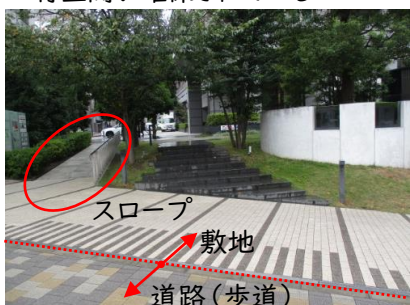
◎道路と高低差のある敷地で、敷地内に緩やかなスロープを設けている
