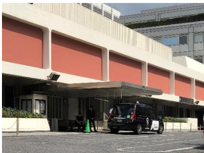
◎病院などの施設出入口からタクシー乗降場まで、連続した上屋が設置されている
