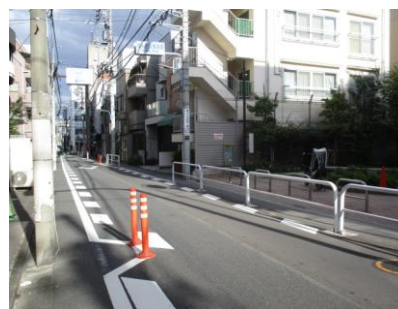
◎狭さくなどの路面表示やポストコーンによる安全対策を実施し、歩行者の安全性に配慮している
