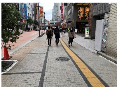
誘導用ブロックの輝度比が確保された歩道整備（新宿駅東南口）
