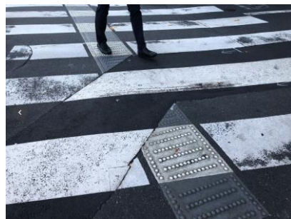
△エスコートゾーンに断絶が起きている
