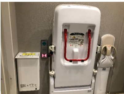
△開閉ボタンが設備の間にあり、車椅子使用者には開閉しにくい
