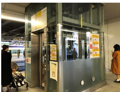
新宿駅東口・西口階～南口階間のエレベーター整備(7・8番線)
