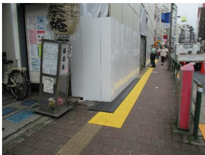
◎工事中安全に迂回できる経路に誘導用ブロックを仮設し、交通誘導員による安全な誘導に配慮する
