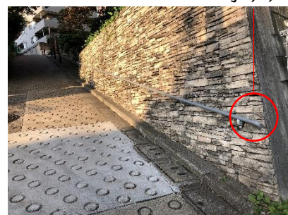
◎急な勾配の坂道沿いの敷地に手すりが設置されている
