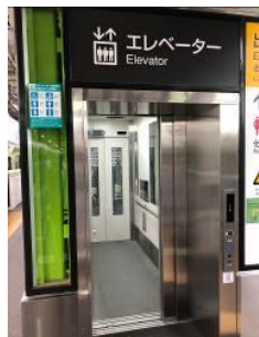
◎スルー式のエレベーターは、車椅子使用者等が転回する必要がなく利用しやすい
