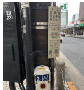
◎幹線道路などの横断距離が長い道路で、音響式信号機や青延長用押しボタン付き信号機の整備がされている
