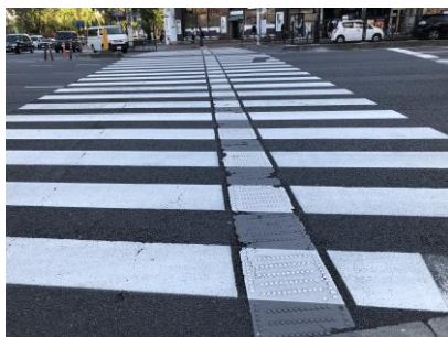
◎横断歩道における視覚障害者の安全な横断のため、エスコートゾーンが整備されている
