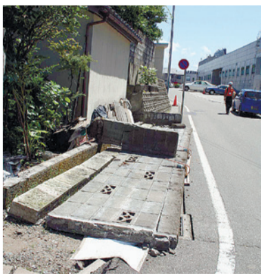
▲ブロック塀倒壊の例(平成19年新潟県中越沖地震)/提供:消防科学総合センター
