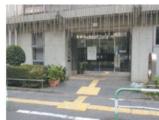
▲道路と敷地内と施設出入口まで、素材・色などが統一された誘導用ブロックが連続して設置されている
