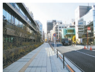
▲敷地と道路に段差のない一体的な歩行空間が確保され、敷地内に誘導用ブロックが設置されている
