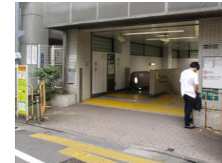
誘導用ブロックが連続していない中井駅の出入口
