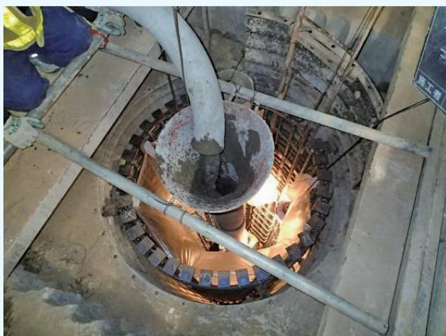
① 工事桁仮橋脚コンクリート打設状況
