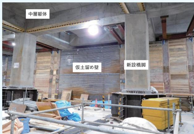
⑤ B2 階仮土留め壁設置状況 (二次掘削完了後撮影)
