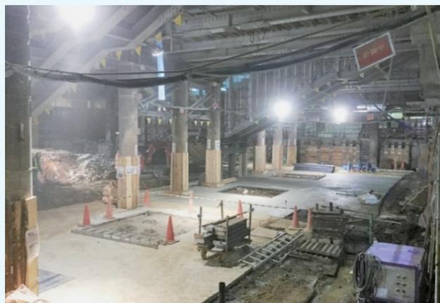
② B1階コンクリート打設完了状況 (新設高架橋基礎作業床構築工事)
