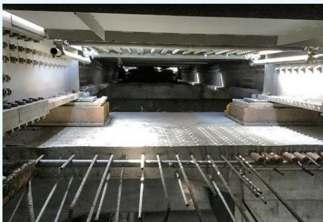
① 新設高架橋脚への工事桁受替状況
