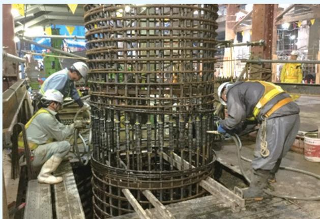
① 鉄筋かご設置状況 (新設高架橋脚基礎杭)
