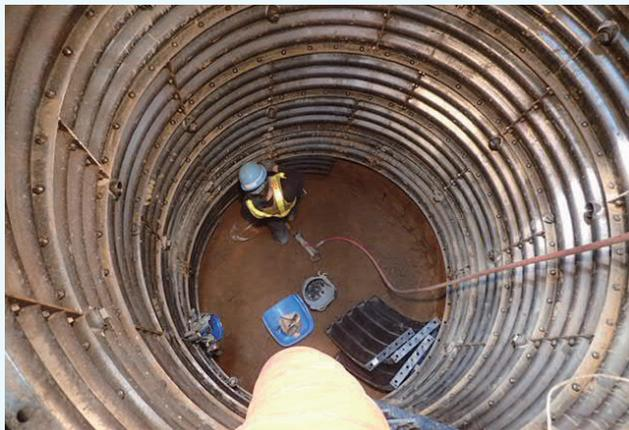
③ ライナープレート設置状況 (新設高架橋基礎工事)
