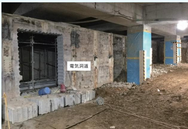
③既設構造物撤去状況（電気洞道）
