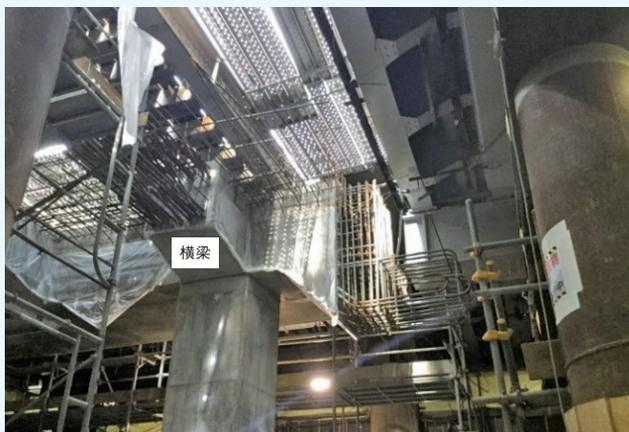
③ 横梁構築状況 (新設高架橋脚)
