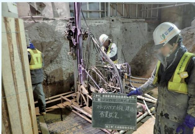
③ 薬液注入状況 (新設高架橋基礎工事)
