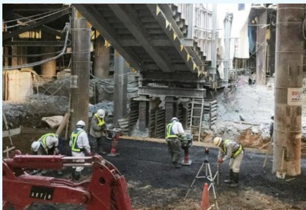
② B1階砕石敷均し状況 (新設高架橋基礎作業床構築工事)
