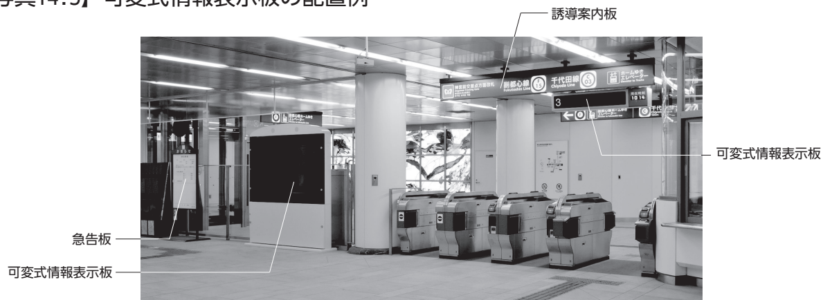
【写真14.5】 可変式情報表示板の配置例
