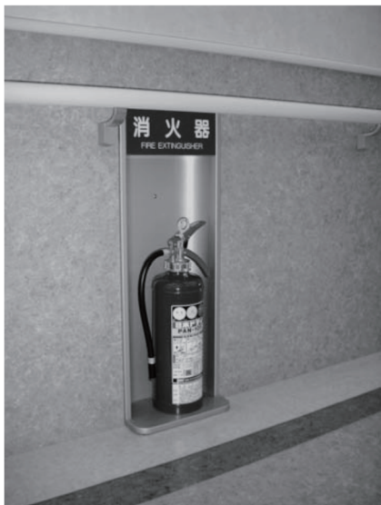
・歩行の障害とならないように、壁に埋め込まれた消火器置場
