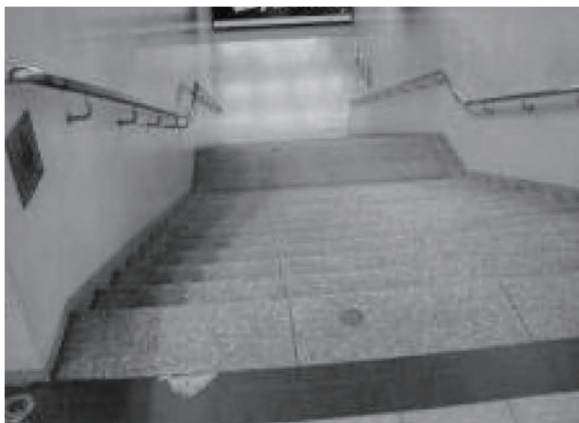
・コントラストがなく、段鼻が認識しづらい
