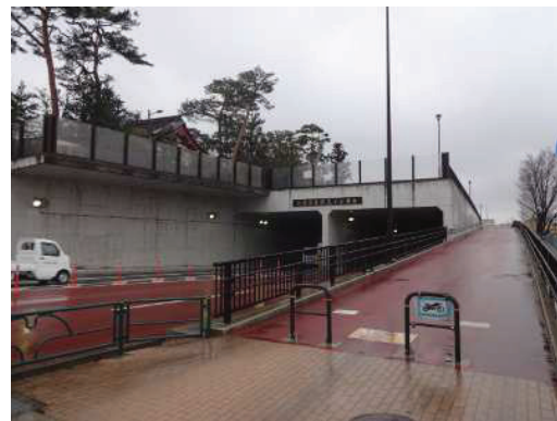
◇道路整備事業と連携した公園整備 (東伏見公園：西東京市)
