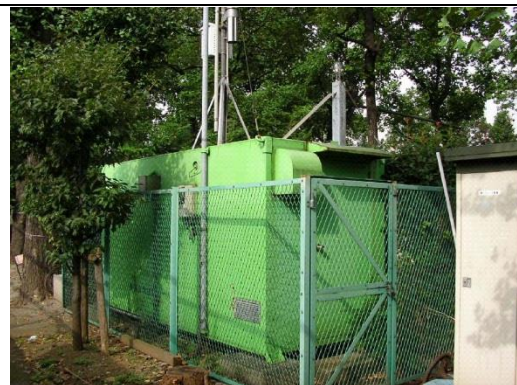
四谷自動車排出ガス測定局
