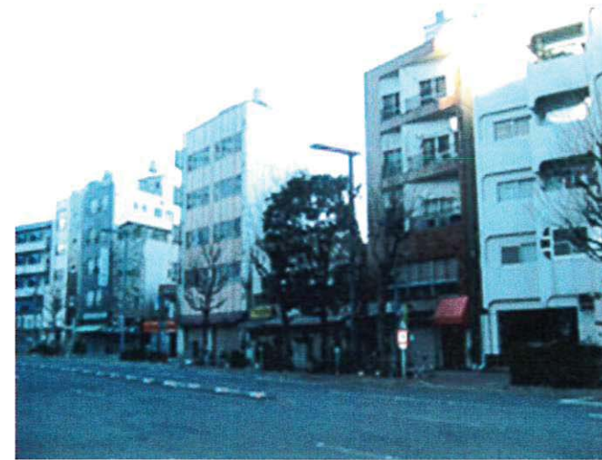
① 十二社通り沿い建物 (店舗、事務所、賃貸住宅) ・青梅街道と十二社通り沿道は老朽化した旧耐震の耐火建築物が多い。
