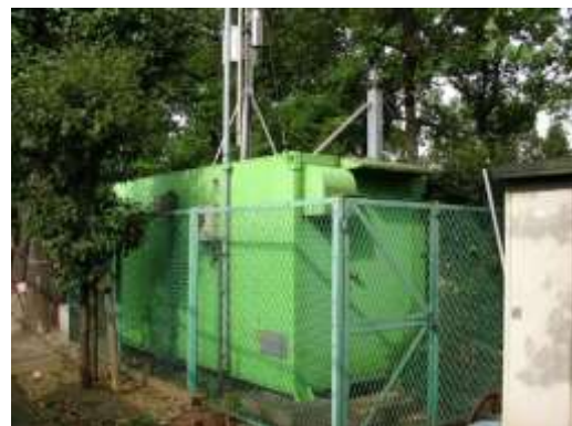
四谷自動車排出ガス測定局
