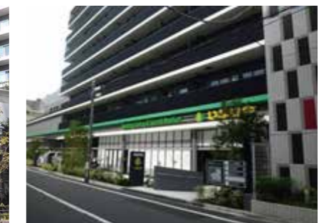
飯田橋ガーデンフラッツ(新小川町)
