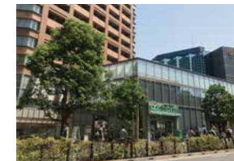
飯田橋プラーノ(千代田区)
