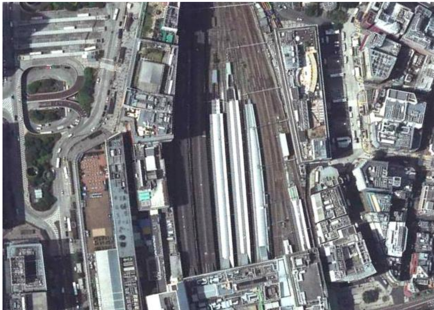
▲線路上空の未利用空間
