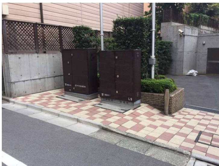
道路外の敷地を活用した地上機器設置事例 特別区道23-1361 (聖母坂通り)
