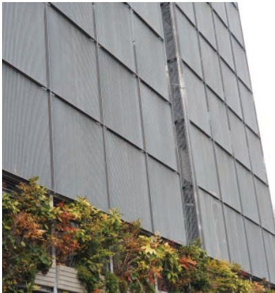
壁面の設備修景
