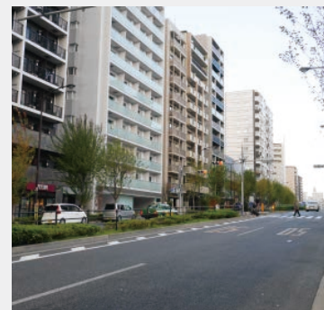
幹線道路沿いの住宅
