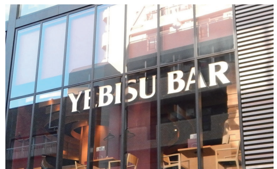
窓面から離し店内に箱文字を設置した例
