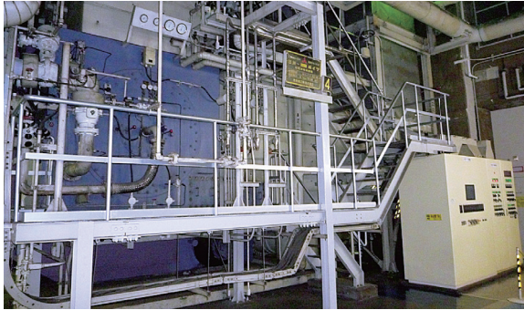
地域冷暖房(西新宿) | 写真提供: 東京ガス株式会社
