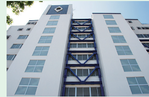
マンションの耐震改修工事の事例
