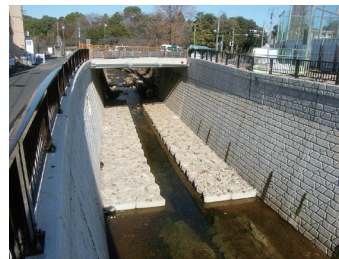
妙正寺川の護岸改修
