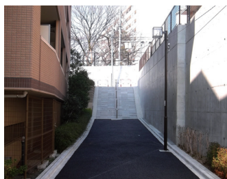
改修した擁壁(写真右側)
