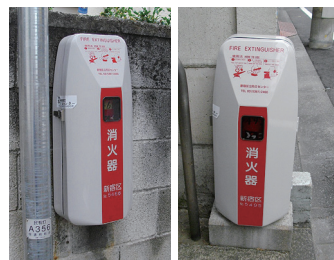
街頭消火器の設置例
