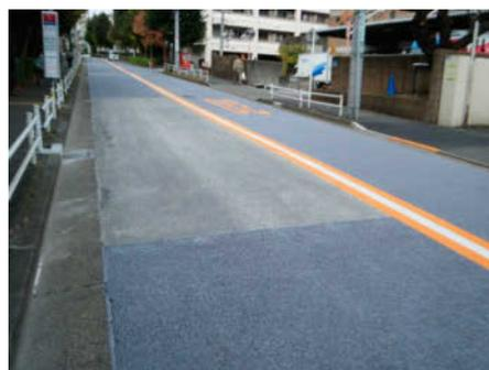
遮熱排水性舗装の施工状況(西新宿二丁目地区)
