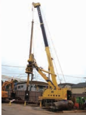
現場での作業風景
