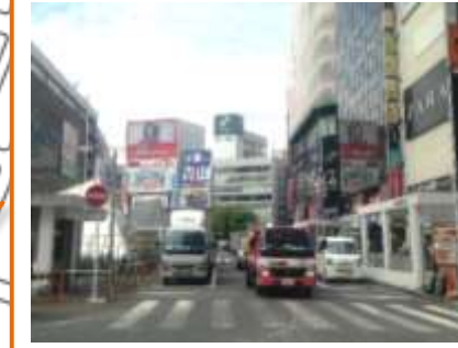
新宿駅東口地下駐車場入口箇所
