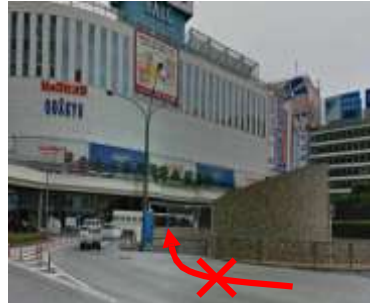
新宿駅西口駐車場地北側入口 (この入口は閉鎖されている。)
