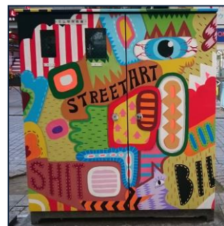
分電盤のペインティング
